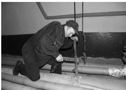
Слесарь-водопроводчик 5 разряда Д. Лазарев проводит замену впускного крана
